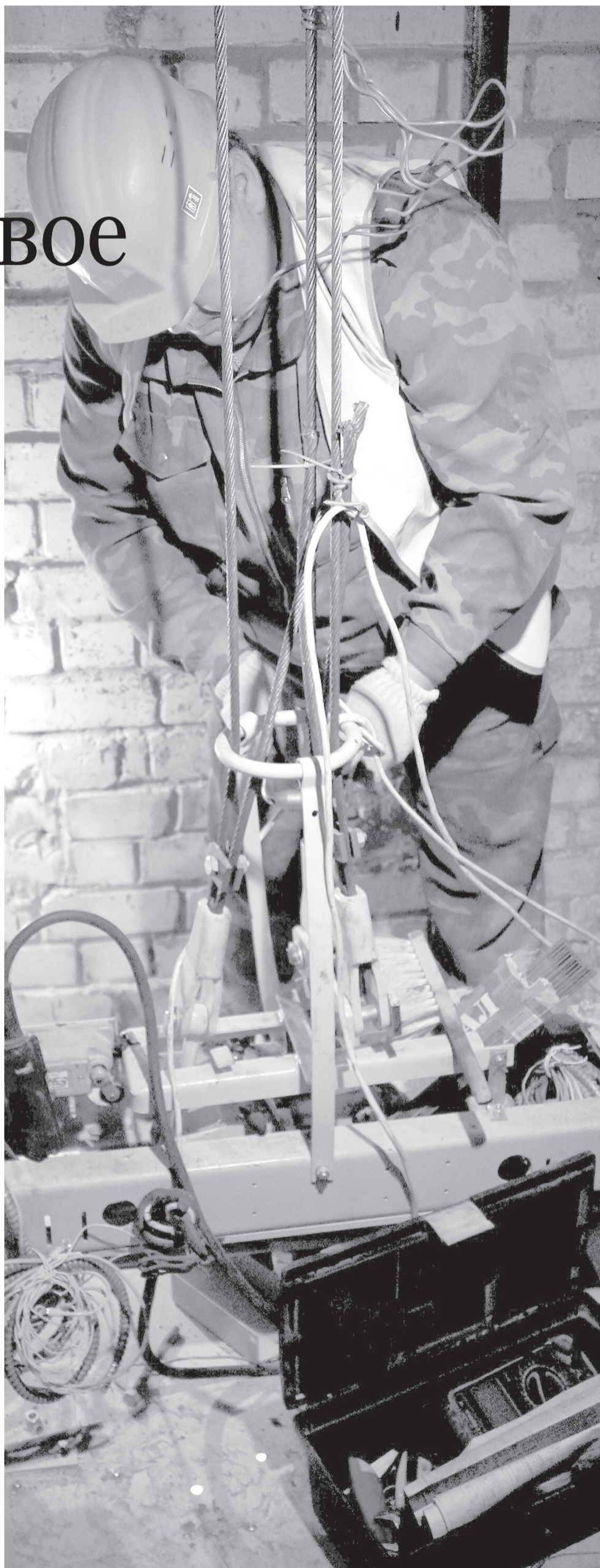
Пока верстался номер, стало известно, что по требованию прокуратуры Ульяновской области расторгнут незаконный договор на выполнение работ по замене лифтов стоимостью более миллиарда рублей. Теперь органам власти необходимо провести новый отбор и заключить договор подряда на проведение капремонта в соответствии с действующим законодательством.
